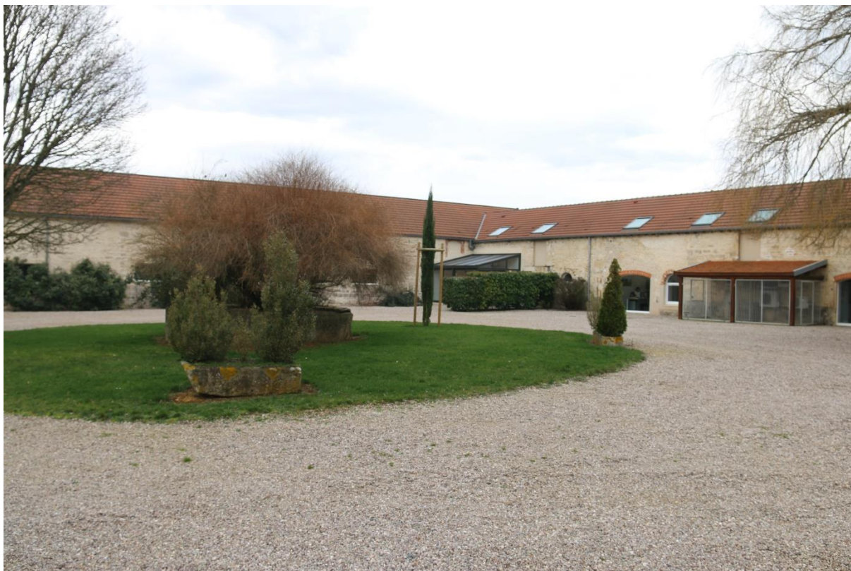
Les bâtiments anciens de la ferme de la Lucine. Photographie prise le 15 février 2024.
