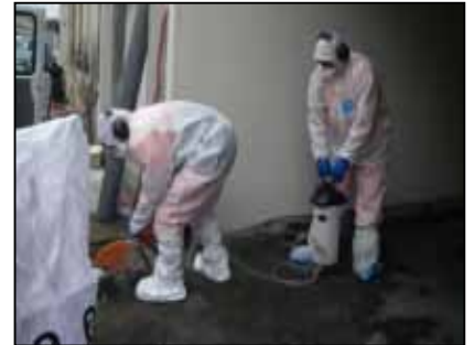
Sciage de chaussée
