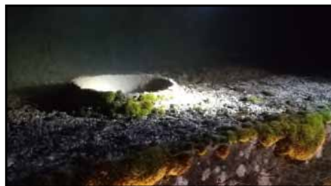
Exutoire du déversoir d'orages 1
