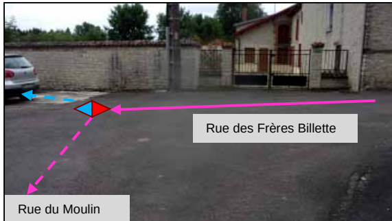
Déversoir d'orages 1 : Rue du Moulin
