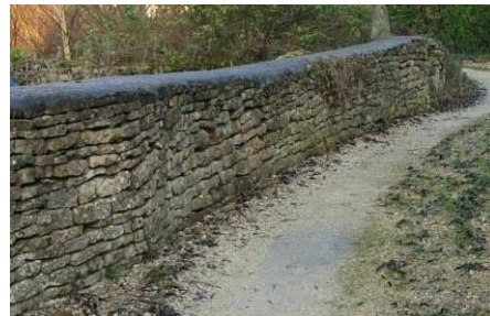
Murs d'assises régulières de pierre calcaire sans joint apparent et couronnement en pierre de lave (gauche) et glacis en mortier (droite)
