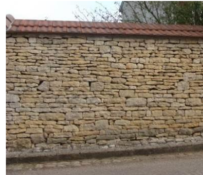
Murs d'assises régulières de pierre calcaire sans joint apparent et couronnement en petites tuiles plates ou en tuiles mécaniques
