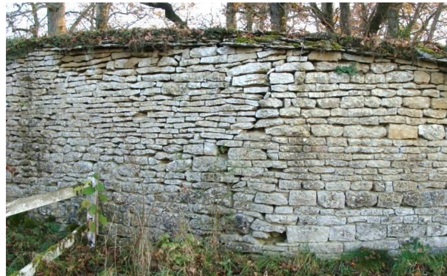
Mur d'enceinte du parc aux daims près de la rue de Richebourg et du couvent des Cordeliers, constitué de belles assises de pierre calcaire sans joint, et d'un couronnement en pierre de lave.
