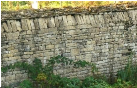
Murs d'assises régulières de pierre calcaire sans joint apparent et couronnement en pierre de lave (gauche) et glacis en mortier (droite)
