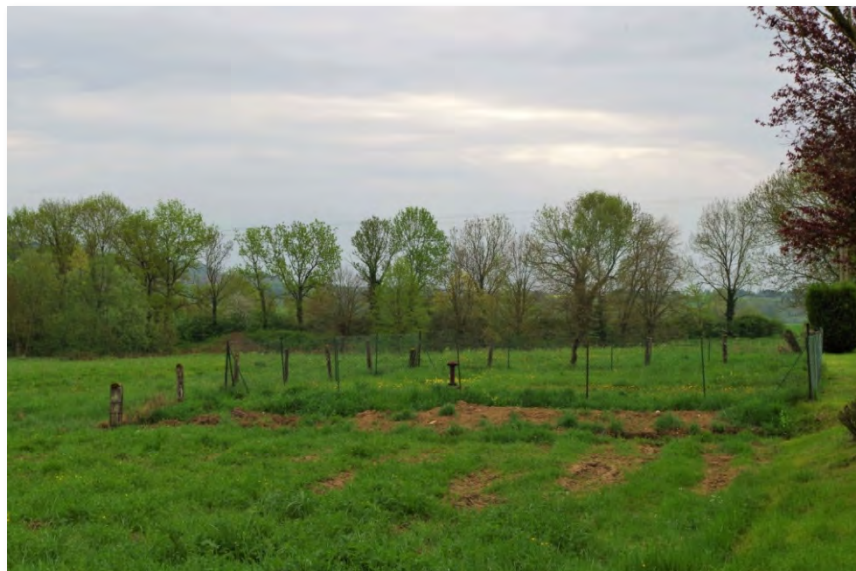
Photographie 26 : Captage AEP sur Montheries (Source : Verdi)
