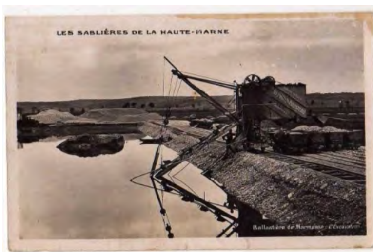
Photographie 1 : Ballastière de Marmesse, « l'excavateur » (Source : www.delcampe.fr )
