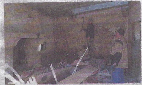
L'opération commence par le démantèlement de l'intérieur...
