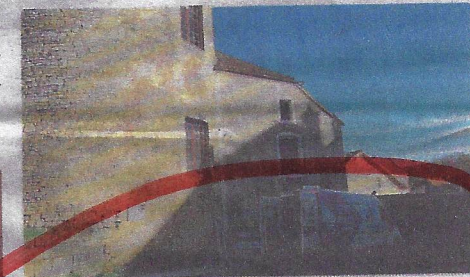
S'ensuivra la démolition de l'immeuble le 17 novembre.
