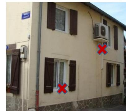
A.9.03 - Les coffrets EDF-GDF s'ils sont indispensables, sont encastrés dans la maçonnerie des murs de soubassements ou des murs de clôture. Ils peuvent être incorporés dans des niches fermées par portillon peint, conformément au nuancier départemental. Les boîtiers techniques des branchements divers seront encastrés dans la maçonnerie.
