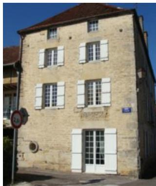
A.6.12 - Les rejointoiements au ciment gris ou à joints marqués, en creux ou en relief, sont proscrits.
