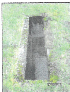
Canal de sortie
