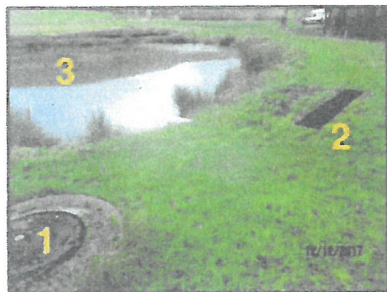
Poste d'alimentation (1) Canal d'entrée (2) 1 ère lagune (3)
