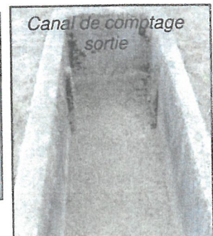
Sortie 3 ème lagune Niveau de l'eau trop bas
