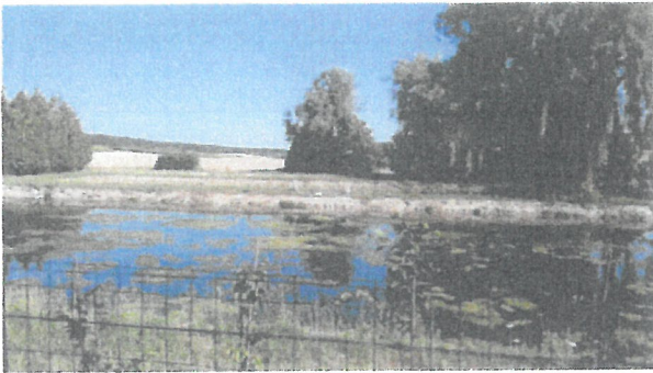
Arrivée des eaux usées sur la station et première lagune
