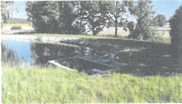
Arrivée des eaux usées Bac dégraisseur de la 1 ère lagune
