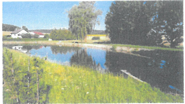
1 ère lagune (Surface : 2000 m 2 environ)
