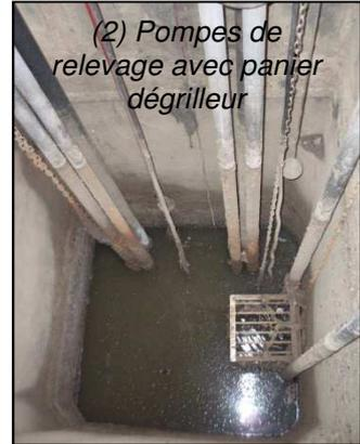
(2) Pompes de relevage avec panier dégrilleur
