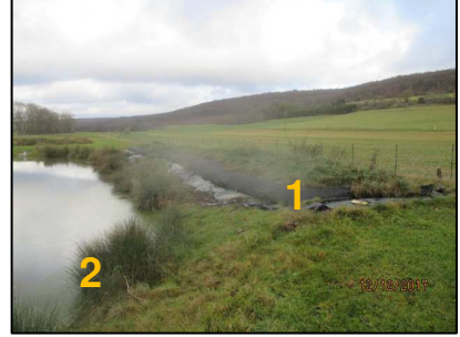
Traitement des boues (1) et 1 ère lagune (2)
