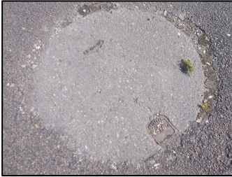
L'un des regards non ouvrables rue du Moulin
