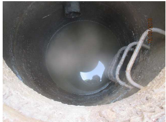
R16 : plein d'eau suite à la montée en charge du réseau lors de l'arrêt de la STEP
