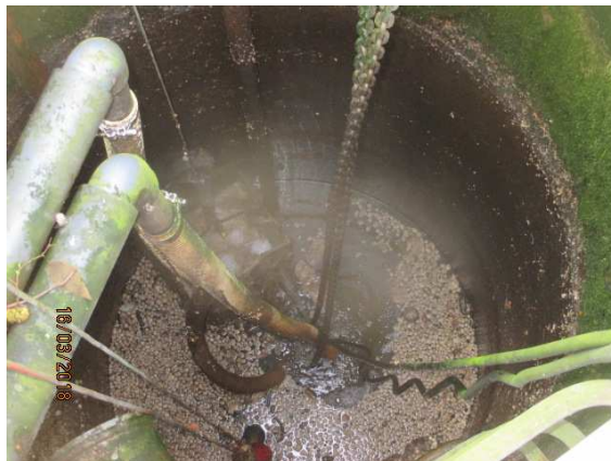
Poste de relevage avec dégrilleur et deux pompes de relevage
