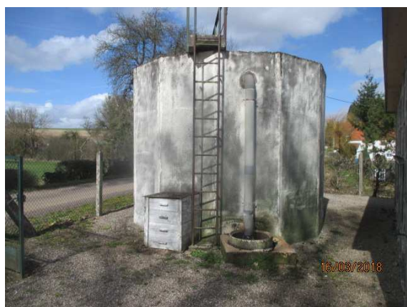
Décanteur digesteur
