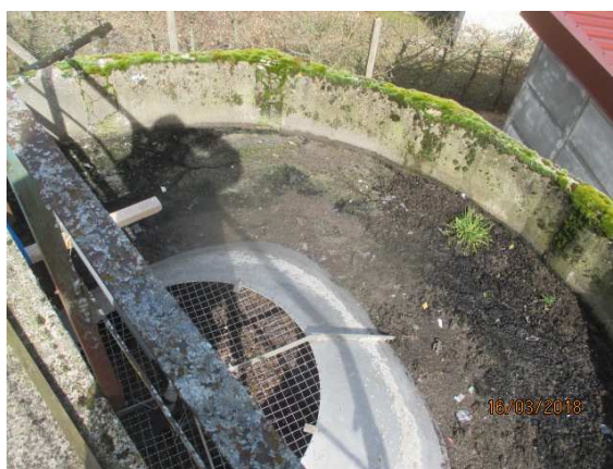
Décanteur digesteur
