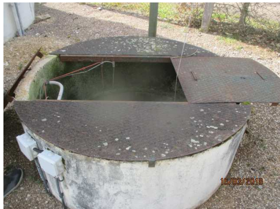
Poste de relevage avec dégrilleur et deux pompes de relevage
