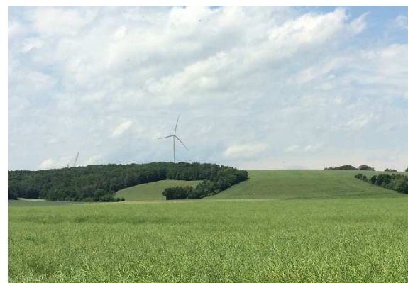
Figure 6 : Parc éolien en cours d'implantation à Essey-les-Ponts (Source : Verdi)
